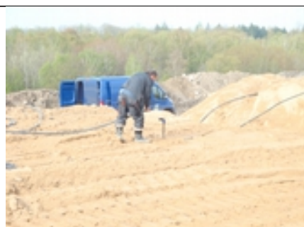
Vystrojování deponie technologií
