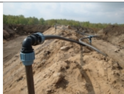
Aplikační sonda, rozvody
