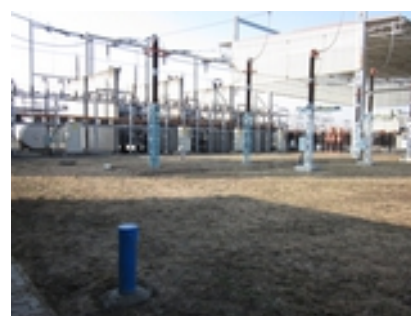
Realizovaný vrt MV-6 na odtoku z T203
