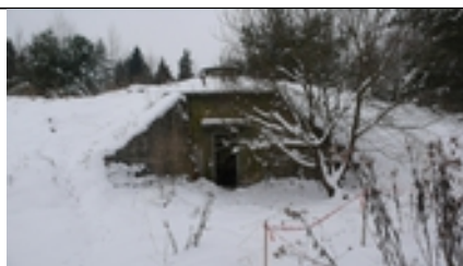
Nadzemní nádrže - Janská
