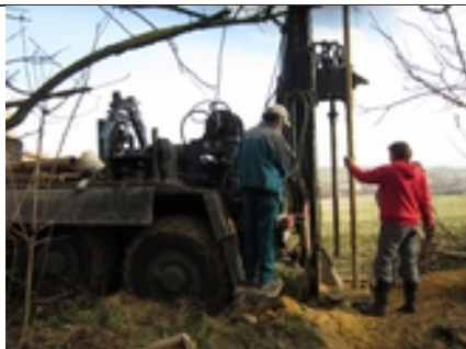
Vrtné práce – skládka Traplice
