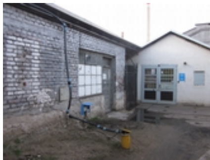
Sanační čerpání z vrtu HP-203
