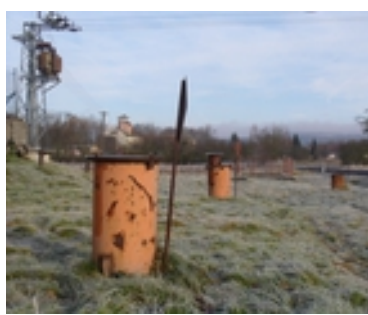
Monitorovací vrtů v blízkosti DS
