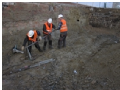
Realizace aplikačních sond na dně výkopu
