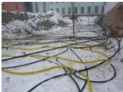
Aplikační sondy s rozvody na dně výkopu
