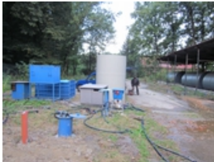
Vláček - zázemí sanační techniky
