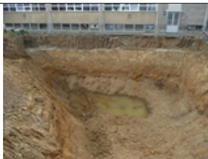
výkopové sanační práce
