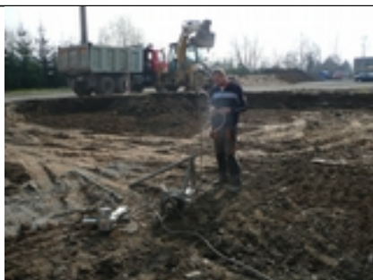
odběr vorků při výkopových pracích
